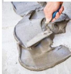
**1** Colocar el adhesivo en una llana dentada y se esparce con la parte plana, presionando para que se impregne en el muro o piso.
