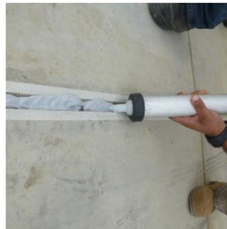
6 Se puede aplicar de manera manual o con pistola neumática.
