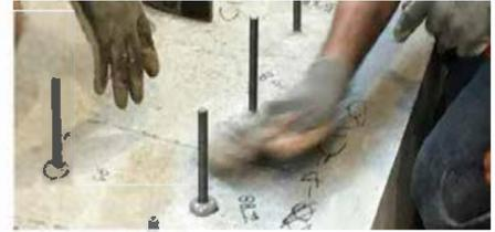
El adhesivo CHEMIFIX CH200 funciona como varillas de construcción embebidas en sitio ...
