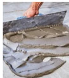
**3** La postura del cerámico requiere ejercer cierta presión, logrando una adecuada nivelación y un contacto efectivo entre el adhesivo y el revestimiento.
